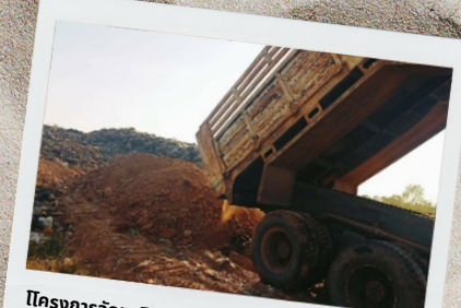
โครงการจัดหาดินสำรองเพื่อใช้ในการฝังกลบมูลฝอย
